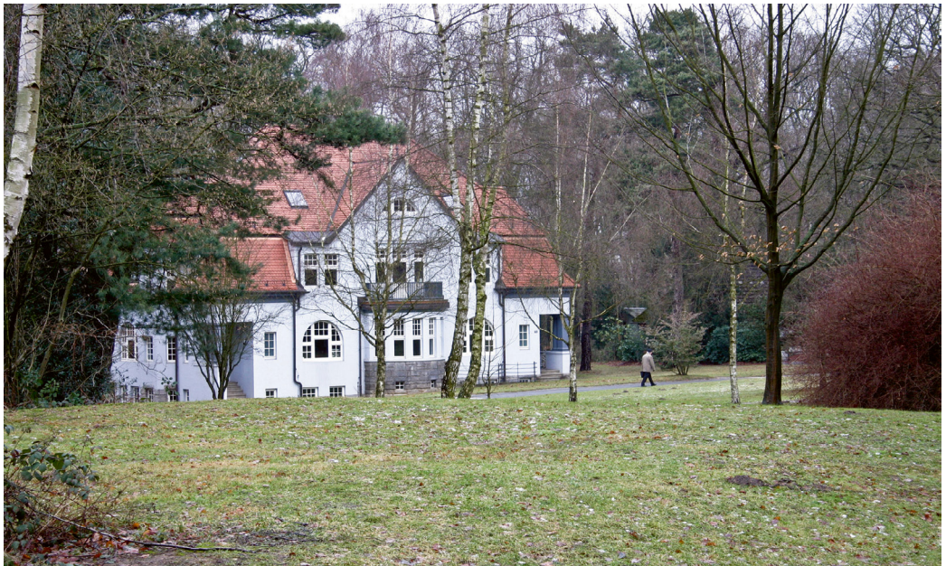
Das große Beamten-Wohnhaus liegt inmitten des idyllischen Teleskoparks.
